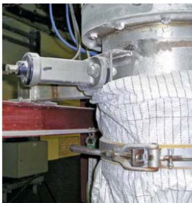
配管のクリーニング
