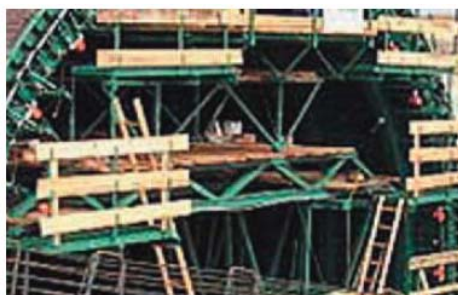
トンネル工事でのコンクリート充填
