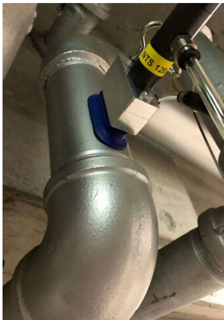
写真 3-2. 残渣付着・閉塞の解消事例、 ピストンバイブレータ NTS120NF+バキュームクランプ
